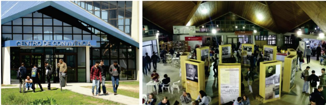
Figura 13. Prédio do Centro Convivência.
